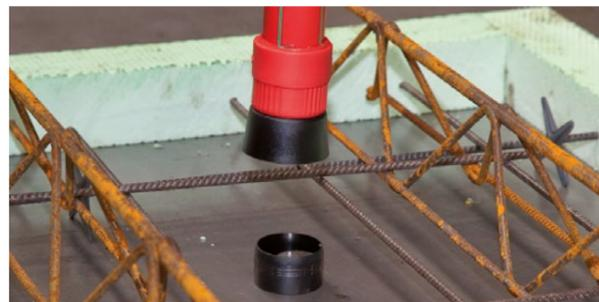
Das Oberteil der Sprinkleranschlussdose, mit Rohranschlussstutzen, wird auf das Unterteil der Sprinkleranschlussdose aufgesteckt.
