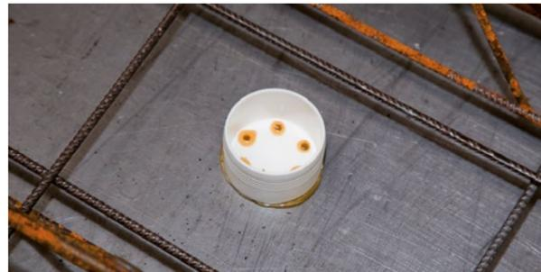
Unterteil Sprinkleranschlussdose Art.-Nr. 3090000005 für verdeckten Sprinkler. Befestigung mit Heißkleber
