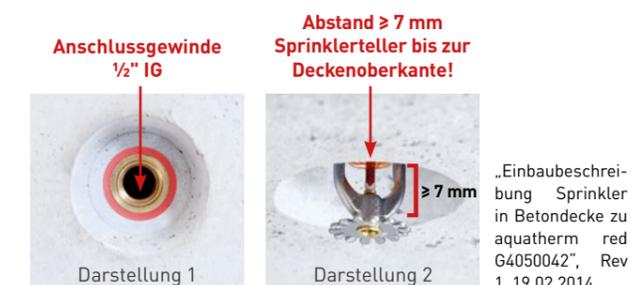
„Einbaubeschreibung Sprinkler in Betondecke zu aquatherm red G4050042“, Rev 1, 19.02.2014
