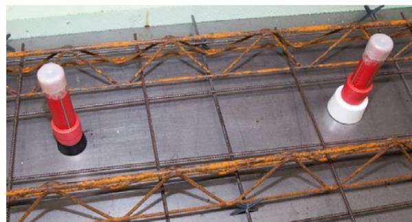
1. Anschlussvariante sichtbarer Sprinkler
