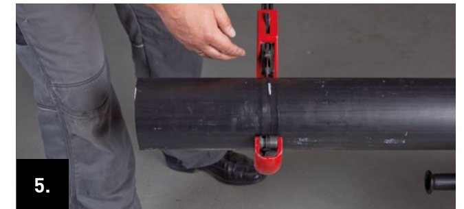
5. Mantelrohr mit Rohrabschneider bis zur PUR-Isolierschicht auf gesamtem Rohrumfang durchtrennen.
