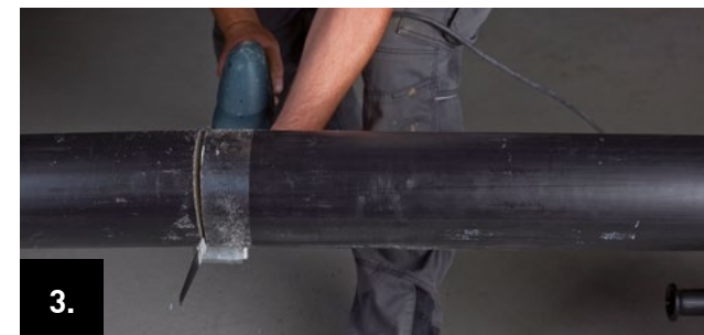
3. Rohr mit handelsüblicher Tigersäge oder Fuchsschwanz mit Sägeblatt für Kunststoff entlang der Schnittlinie durchtrennen.
