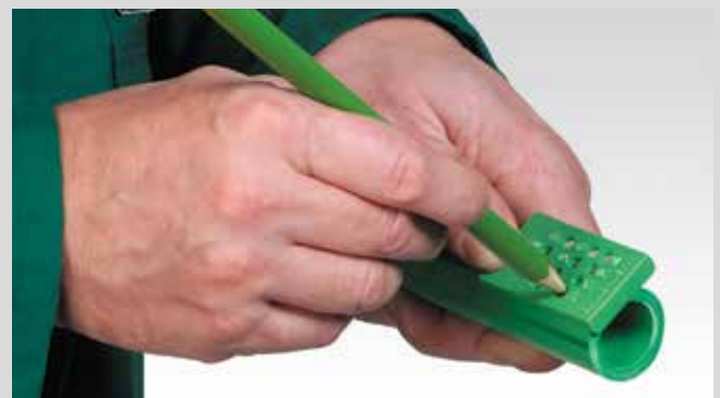
Marcar la profundidad de soldadura
