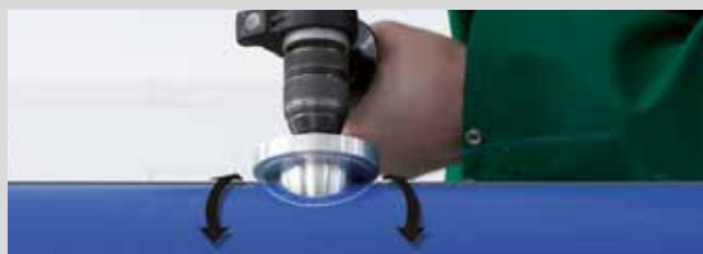
Remoción de la capa de bloqueo de oxígeno en la tubería aquatherm blue pipe OT
