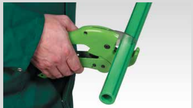
Cortar la tubería
