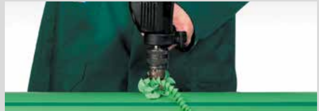
Durchbohren der Rohrwandung
