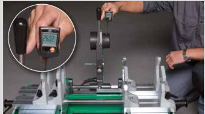
Temperaturmessung an der aquatherm-Schweißmaschine
