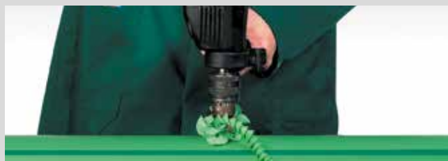
Foratura della parete del tubo.
